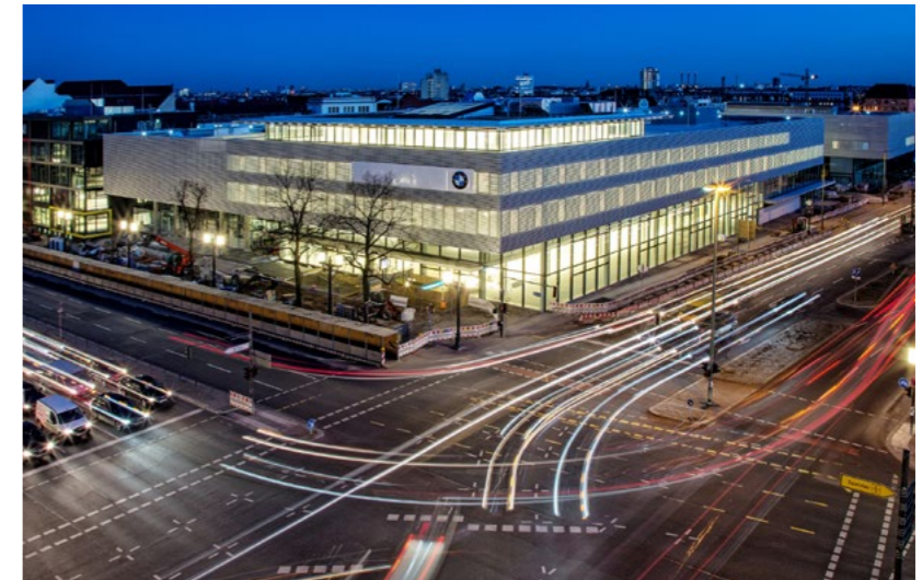
ZUKUNFTSWEISEND — CO 2 neutrales Gebäude der BMW Niederlassung Berlin.
