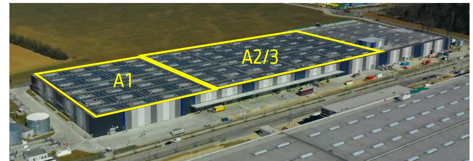
Bild: Photovoltaik-Anlage auf Hallendach 1-3
